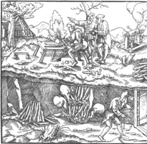
Abb. 32: Feuersetzen zum Lösen des Gesteins unter Tage Neben der wichtigsten bergmännischen Abbaumethode, der Arbeit mit Schlägel und Eisen vor Ort, wurde auch das Feuersetzen unter Tage praktiziert. (Holzschnitt aus Georgius Agricolae Werk „De re metallica“)
